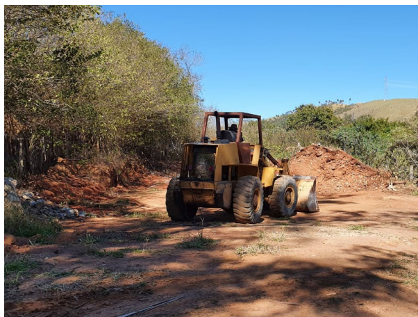
Foto 13: Remoção do Entulho pela PPC Santana (25/08/2020)
