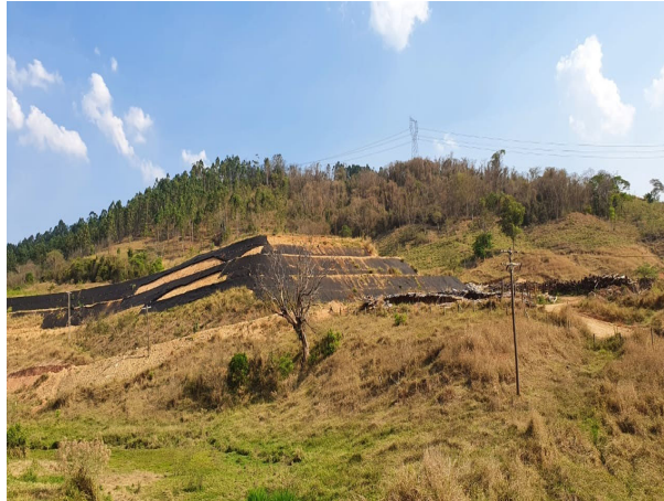
Foto 5: BF 3 Margem direita 31/08/2020
