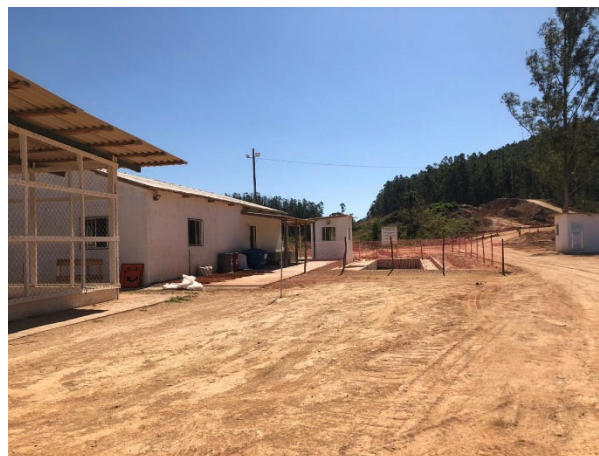
Foto 18: Situação da Construção de Estruturas no Canteiro operacional (07/08/2020)
