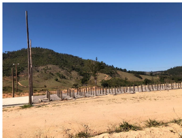
Foto 20: Situação da Construção de Estruturas no Canteiro operacional (07/08/2020)
