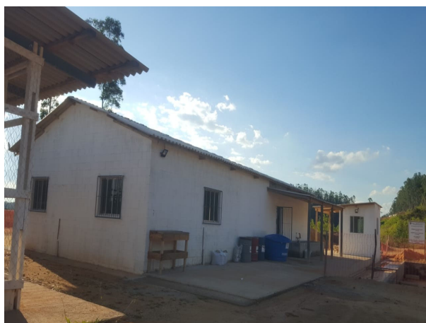
Foto 3: Aviação da Construção de Estruturas no Canteiro operacional (15/05/2020)
