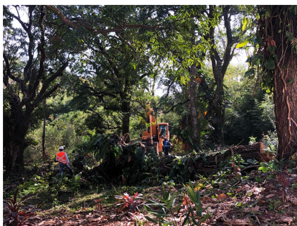
Foto 27: Acompanhamento da atividade de supressão – Canteiro – autorização Defesa Civil (Data: 06/07/2020)
