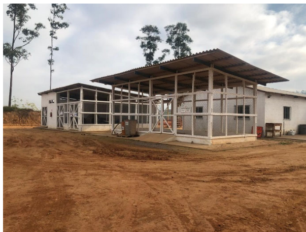
Foto 17: Situação da Construção de Estruturas no Canteiro operacional (09/07/2020)
