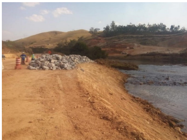
Foto 33: Pré-ensecadeira M1 em construção (30/08/2019)
