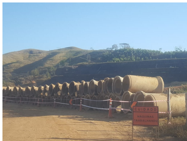
Foto 36: Manilhas removidas da M1 (06/08/2020)
