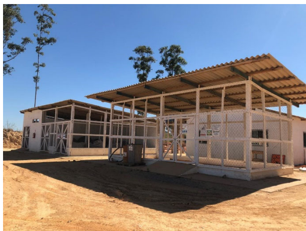
Foto 19: Situação da Construção de Estruturas no Canteiro operacional (07/08/2020)
