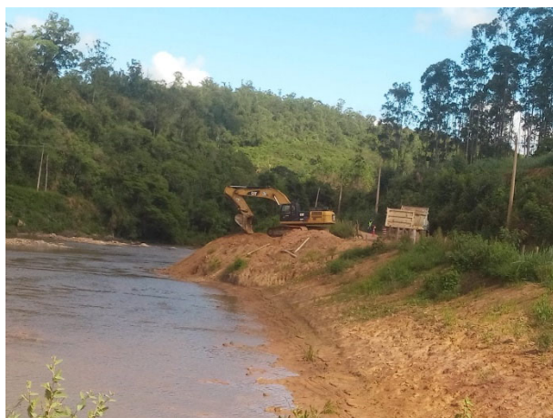
Foto 31: Construção da Ensecadeira J0 (29/01/2020)
