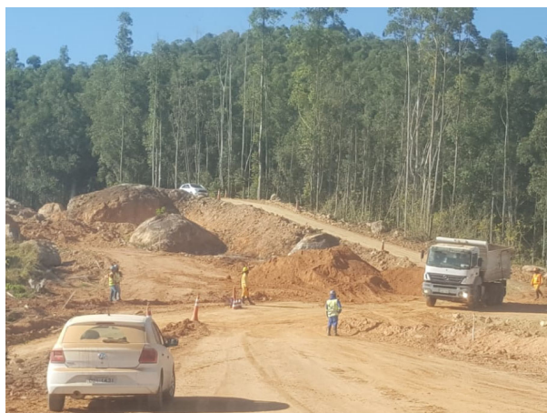
Foto 15: Desmonte de rocha (06/08/2020)
