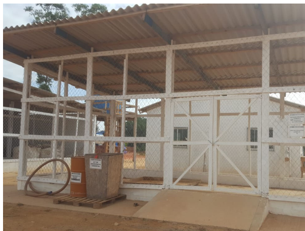
Foto 1: Aviação da Construção de Estruturas no Canteiro operacional (15/05/2020)
