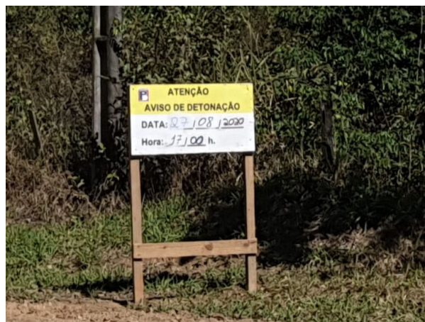
Foto 16: Desmonte de rocha (27/08/2020)
