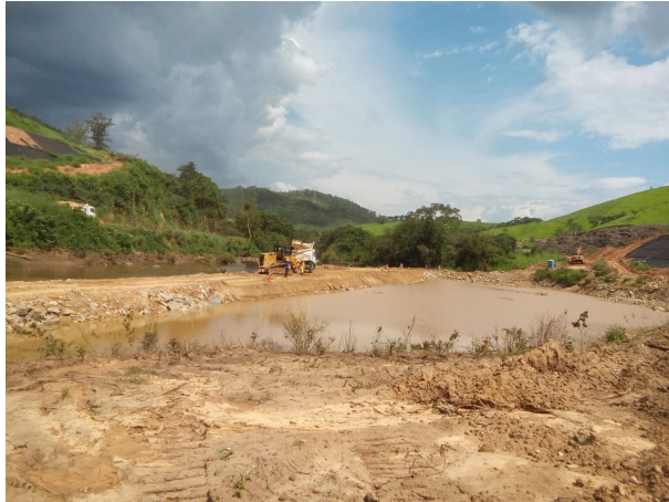
Foto 29: Construção da ensecadeira M0 (31/01/2020)
