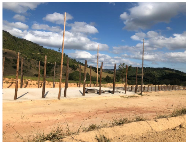
Foto 2: Aviação da Construção de Estruturas no Canteiro operacional (15/05/2020)
