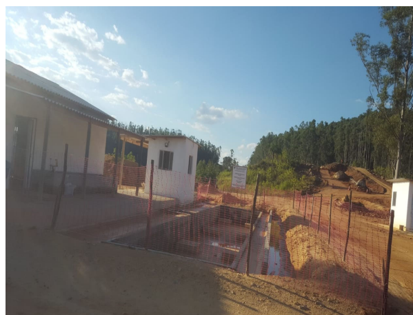
Foto 4: Aviação da Construção de Estruturas no Canteiro operacional (15/05/2020)
